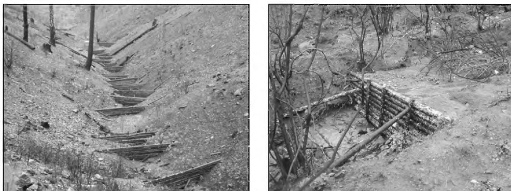
Εικόνες 3α και β. Σειρά ξυλοφραγμάτων (α) και συγκράτηση φερτών υλών (β) στο δάσος Ταϋγέτου.
