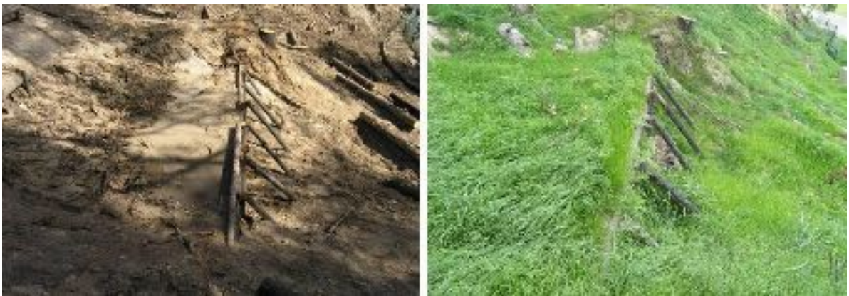
Εικόνα 3. Συγκράτηση εδάφους από κορμοφράγμα στον Κρόνιο λόφο στην Ολυμπία
