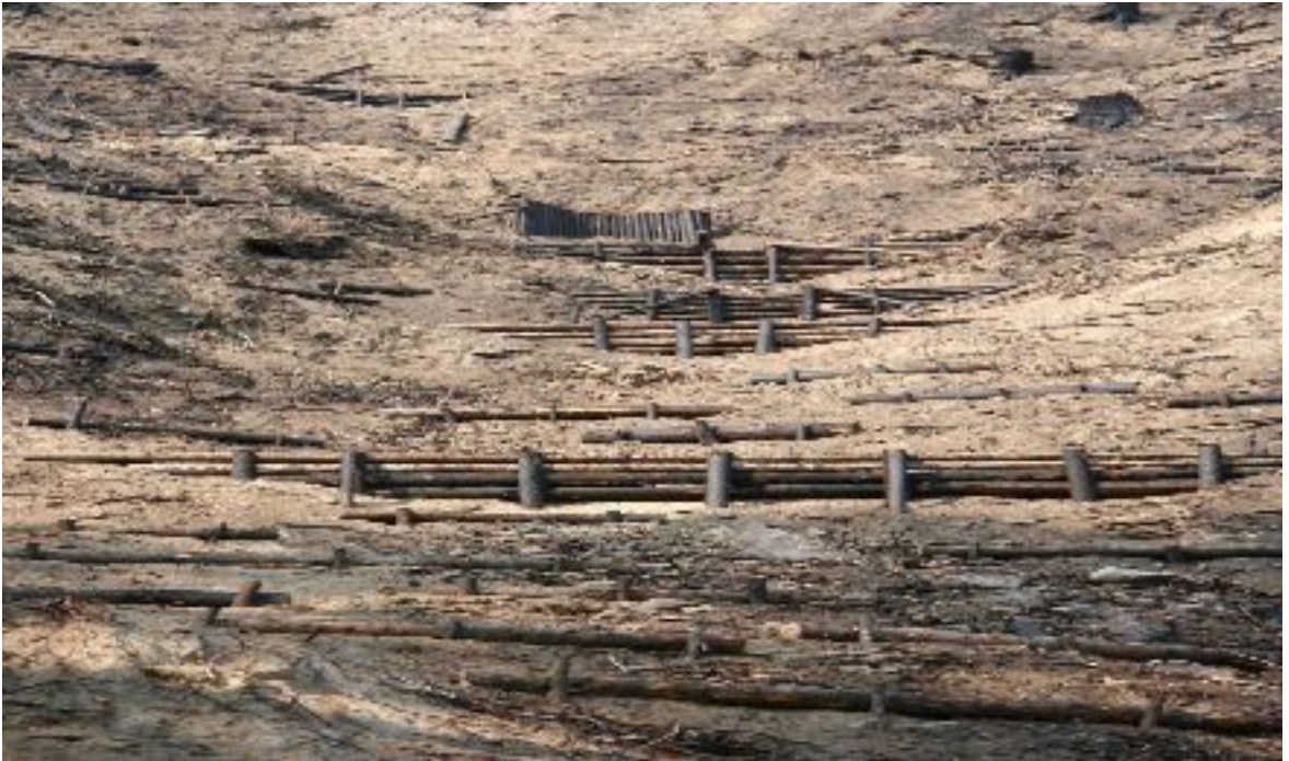
Εικόνα 2. Κορμοδέματα και κορμοφράγματα που δημιουργήθηκαν για την προστασία του εδάφους του Κρόνιου λόφου στην Ολυμπία.
