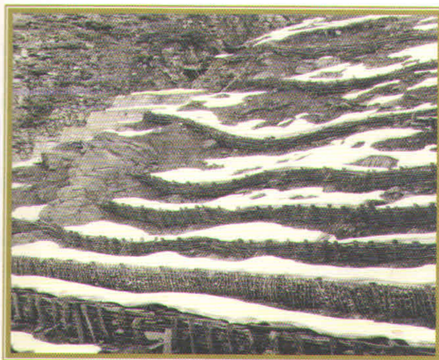
Εικόνα 16. Κλαδοπλέγματα σε υποβαθμισμένη πλαγιά για προστασία του εδάφους από τη διάβρωση.
