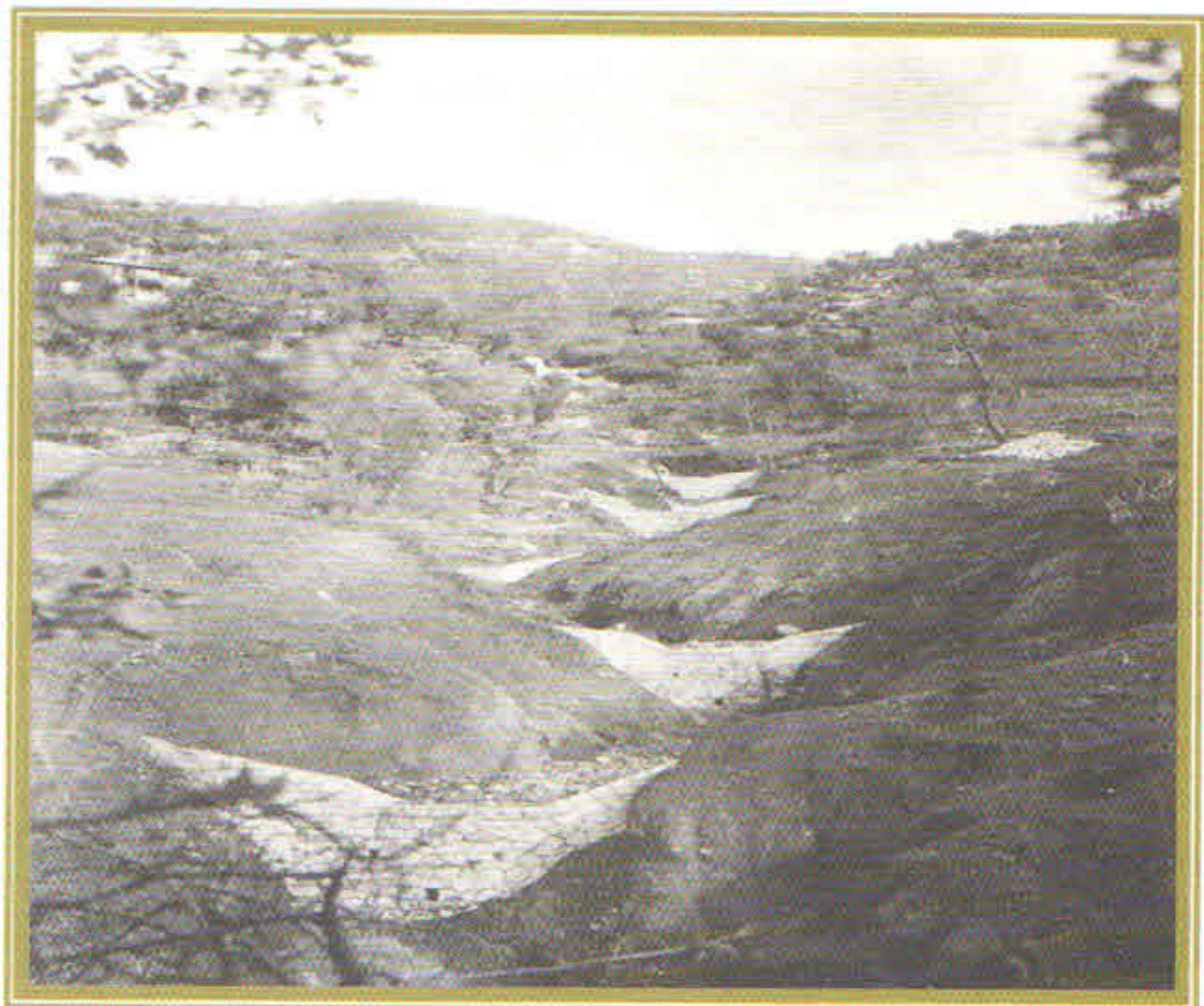
Εικόνα 19. Σειρά φραγμάτων στην κοίτη υδατορεύματος για προστασία αυτής από τη διάβρωση, συγκράτηση φερτών υλών και ρύθμιση της διαίτας
